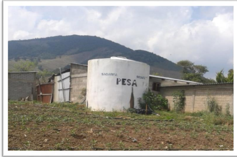
IMAGEN 7.5 Tanque de ferrocemento PESA, Miahuatlán, Oax.
