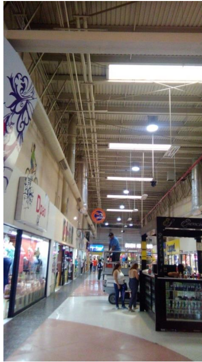
Fotografía 24: Techo Plaza Nuevo Mexicali 3
