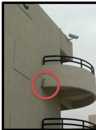
Figura 79. Pared del edificio C
