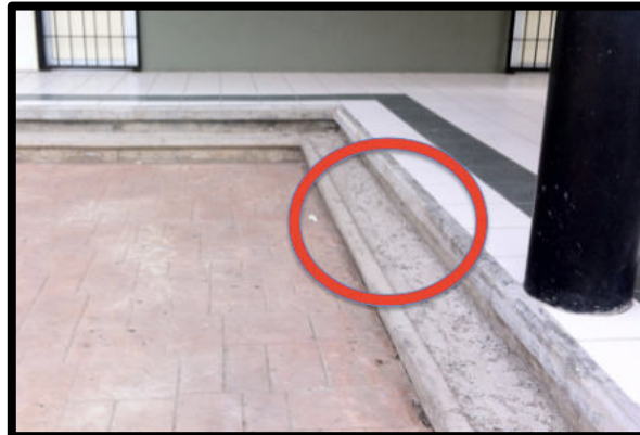
Figura 78. Escalones del edificio D
