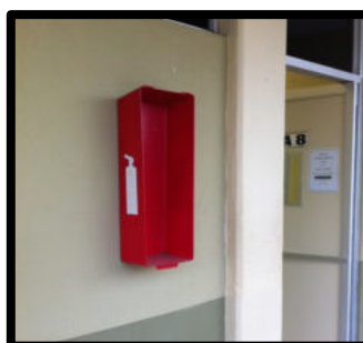
Figura 92. Pieza para extintor localizada en el edificio A
