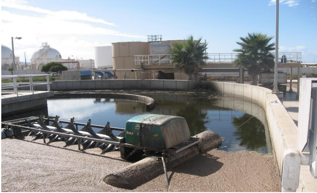
Figura 3. Vista de la Planta de Tratamiento de Agua residual Rosarito Norte (PTARRN)
