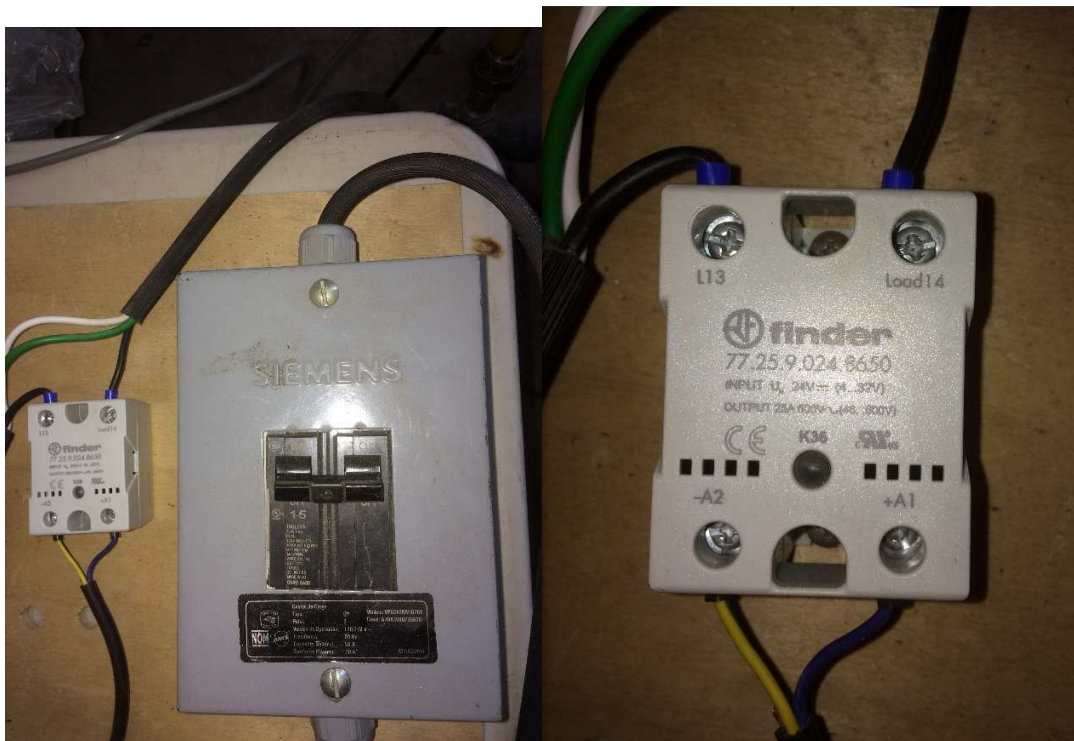
Figura Conexión del Relevador al interruptor de CA
