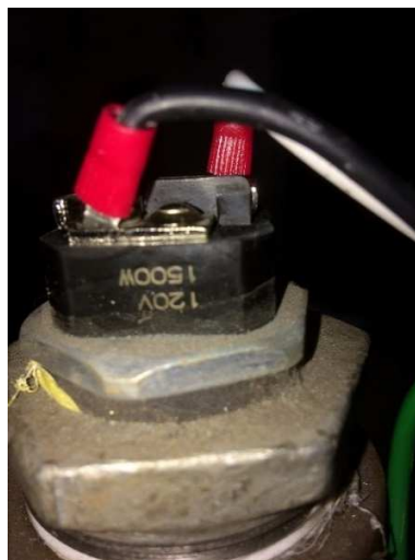
Figura 41. Montaje de la resistencia calefactora
