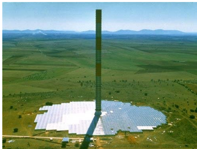
Figura 2.2. Chimenea solar instalada en Manzanares, España.
