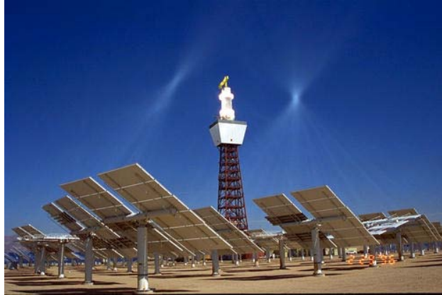
Figura 2.5. Planta de torre central en Barstow, California.
