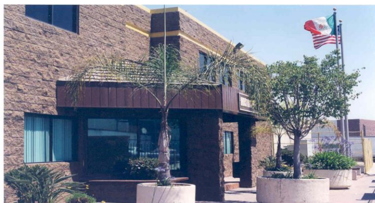
Figura 18. Fachada exterior Electric S.A de C.V. (2013) Fuente: Elaboración propia (2013)
