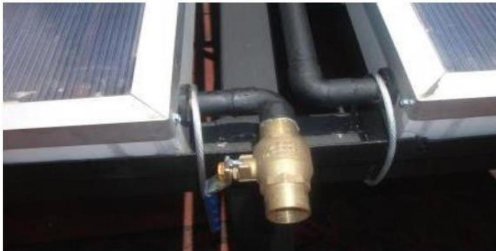
Figura 4.9. Válvula de drenaje o drenado.
