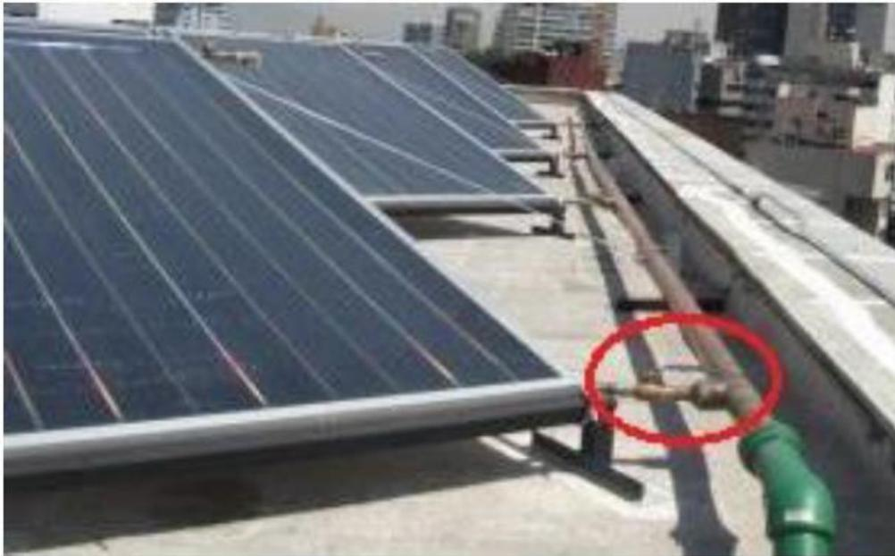
Figura 4.10. Válvulas de corte por banco (serie).
