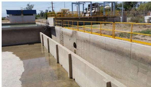
Figura 62. Estructura de entrada del presedimentador.
