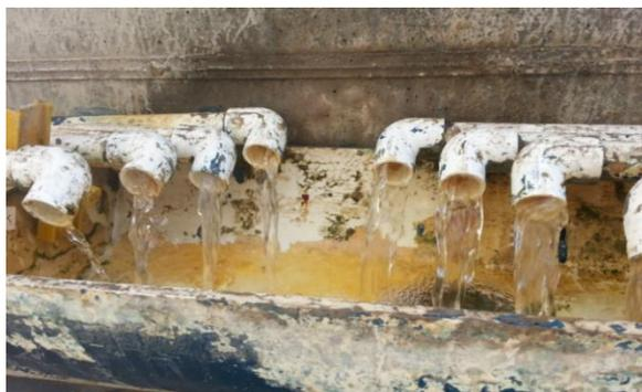
Figura 57. Punto de muestreo de efluente de filtros.
