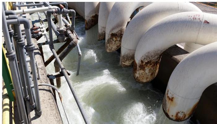
Figura 72. Vista de la unidad de mezcla rápida.
