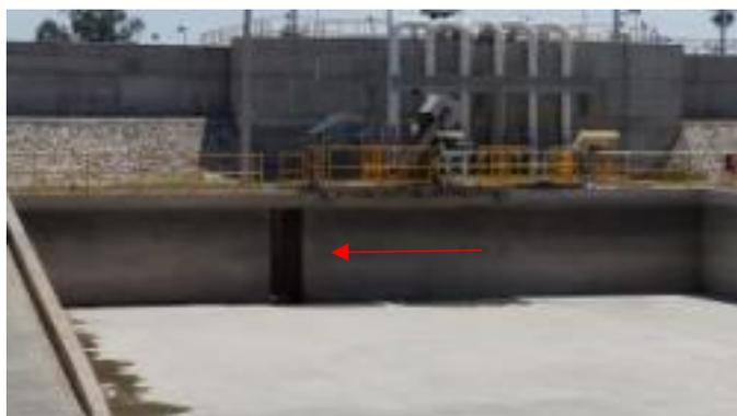
Figura 63. Estructura de salida del presedimentador.
