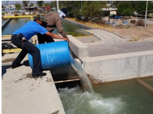
Figura 52. Adición de trazador.
