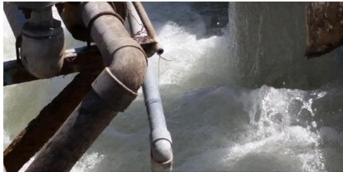
Figura 73. Dosificación incorrecta de coagulante.
