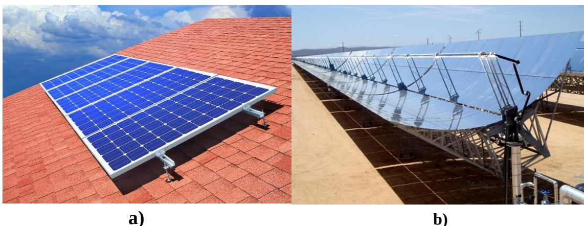
Figura 1. Sistemas de captación solar: a) Arreglo de paneles fotovoltaico (energía eléctrica) y b) Arreglo de colectores solares (energía térmica)
