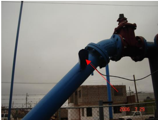
Ubicación del sensor de presión.
