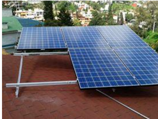
Figura 35.- Huevo en estructura para a completar panel.
