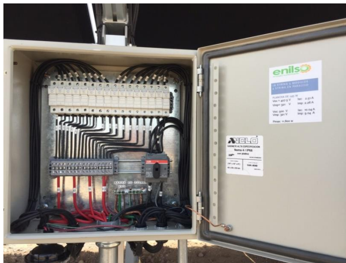
Figura 36 Gabinete panel de 145 W fotografía original del sistema.
