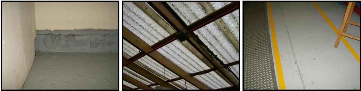
Figura 23 Instalación física del laboratorio de máquinas y herramientas
