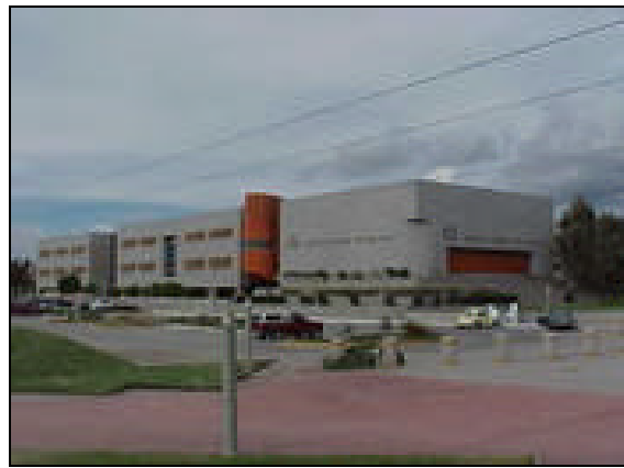
Figura 8. Fuente Fija de contaminación.
