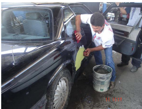
Foto 17. El lijado de la lámina incorpora al proceso, otra fuente de contaminación.
