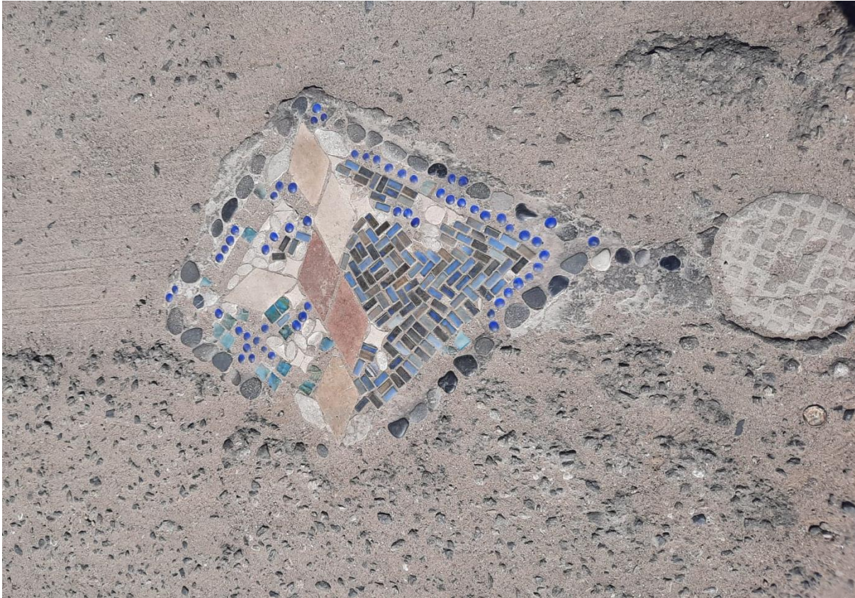
Imagen 12: Primer bache reparado por el colectivo Calle 13
