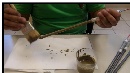
Figura 21.- Aplicación de recubrimiento SikaTop-Armatec 110
