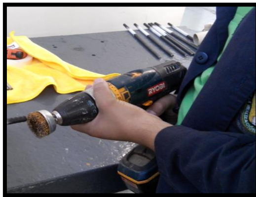
Figura 15.- Cepillado de la parte trasversal de las varillas
