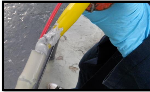
Figura 19.- Inyección del producto Sikaflex-1 a
