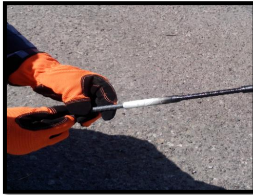
Figura 14.- Varillas pintadas con spray para metal en su extremo
