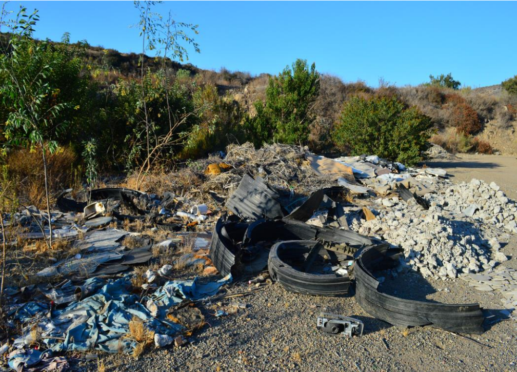
Imagen 2. Tiradero de escombros
