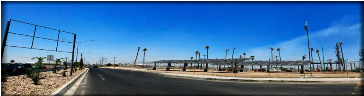
Figura 1.8 Alumbrado Público con Granja Fotovoltaica: Calzada Independencia [21]
