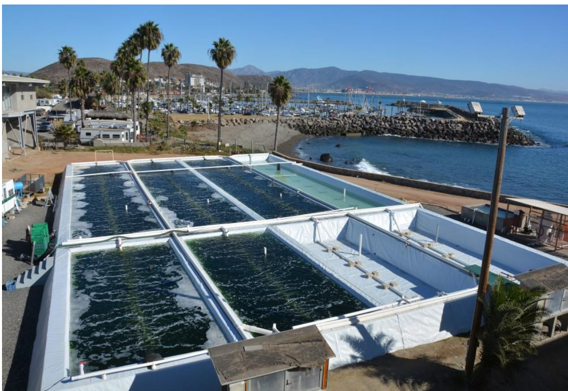
Figura 1 Unidad Acuícola Piloto Comercial (UAPC) del Instituto de Investigaciones Oceanológicas (IIO) en la Universidad Autónoma de Baja California (UABC), Ensenada, Baja California, México. En la parte superior se observan 4 estanques de cultivo de 100 m 3 . En la parte inferior se encuentran 4 estanques de cultivo de 40 m 3 (Unidades experimentales).
