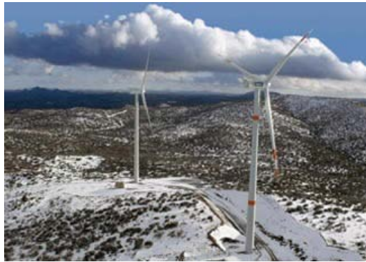
Figura 2.6 Turbinas eoloeléctricas en la Rumorosa, B. C.
