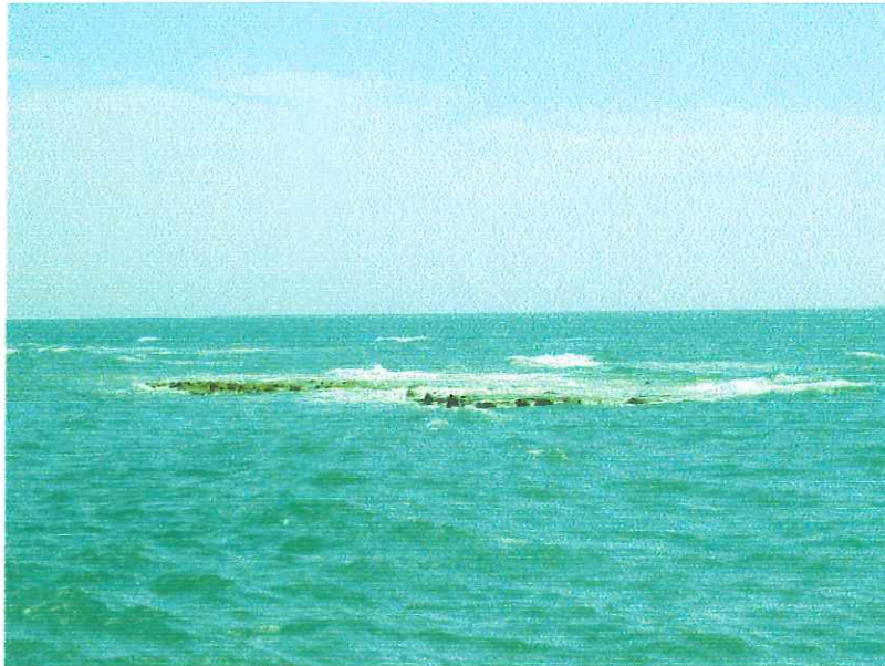
Figura 8. Muestra la rompiente colapsada (collapsing) para la sección "Final Victoria".
