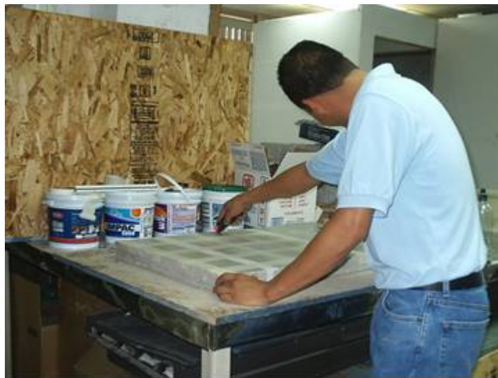
Figura 4.9: Pruebas de demarcación sobre losa de concreto
