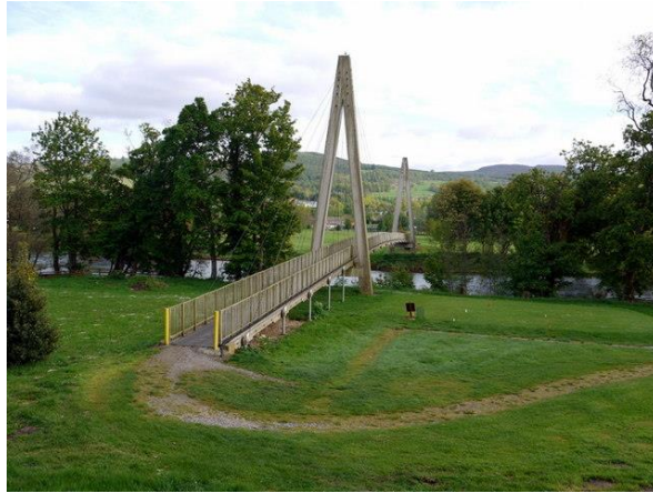
Figura 2–4 Puente de material compuesto Aberfeldy. [61] Foto © Andrew Curtis (cc-by-sa/2.0)
