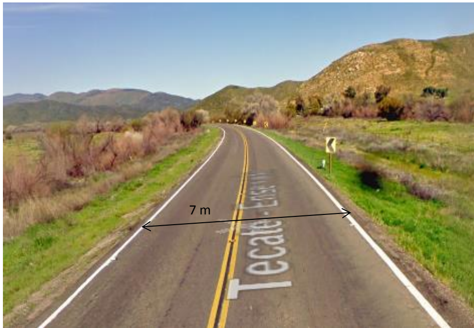
Figura 2-36 Carretera federal primaria 3, Tramo Tecate-Ensenada
