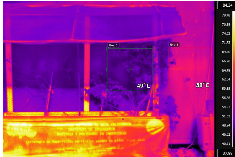
Figura 26. Fotografía térmica sitio experimental 17:00h
