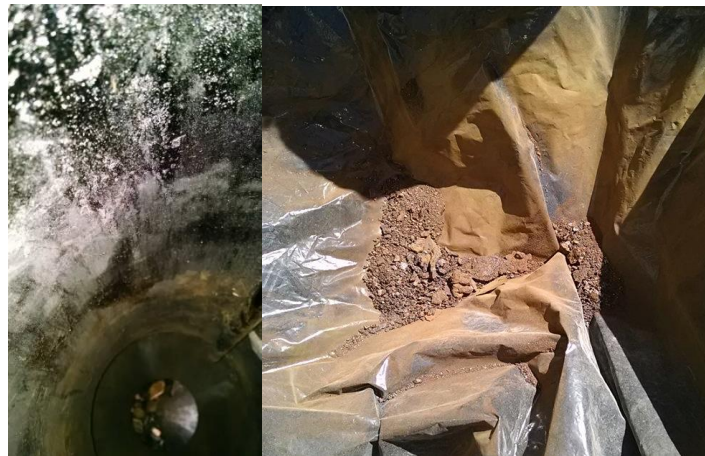
Figura 46 Escoria (izquierda), producto de corrosión (derecha)
