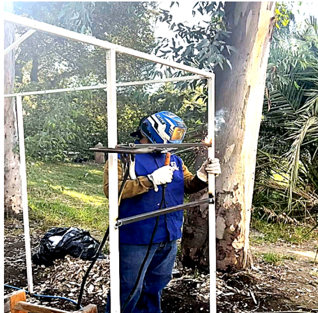
Figura 3.5 Instalación de perfiles metálicos del invernadero académico. Elaboración propia.
