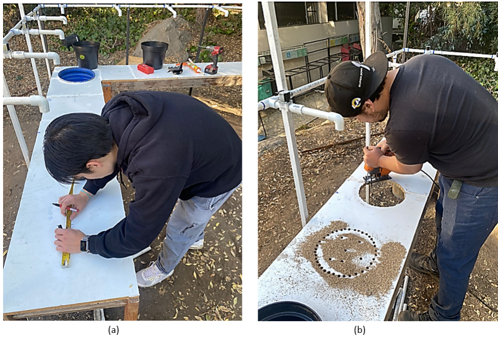
Figura 3.7 Construcción de mesas de cultivos y colocación de electro-válvulas. (a) Diseño en mesas. (b) Perforación de mesas. Elaboración propia.
