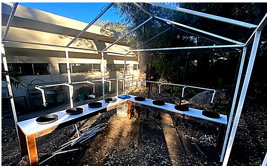
Figura 3.9 Fase 1 de la construcción del invernadero. Elaboración propia.
