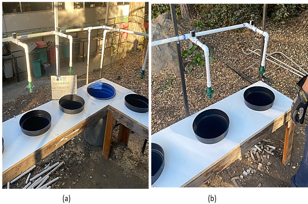
Figura 3.8 Instalación de aspersores en la tuberías de PVC. (a) Vista lateral. (b) Vista frontal. Elaboración propia.
