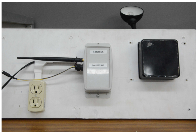
Figura 4.4: Montaje de cámara e iluminación.
