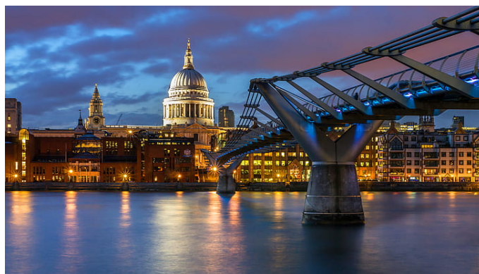
Figura 2.1: Puente Millenium (Londres, Inglaterra).
