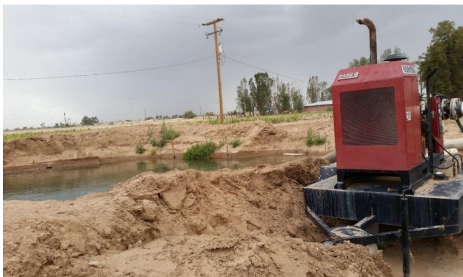
Figura 4.12 Reservorio junto a motobomba del usuario del riego por goteo.
