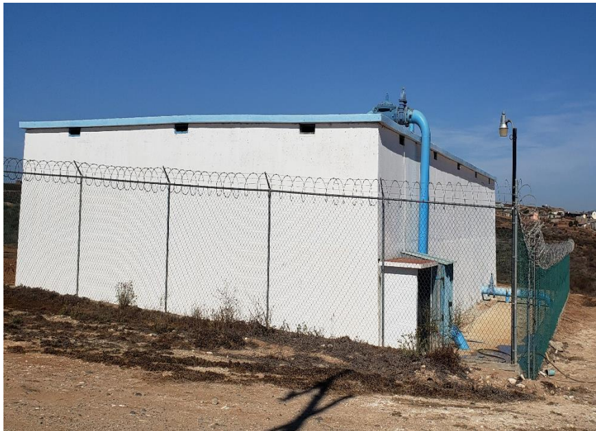
Tanque Regulador A.B.
