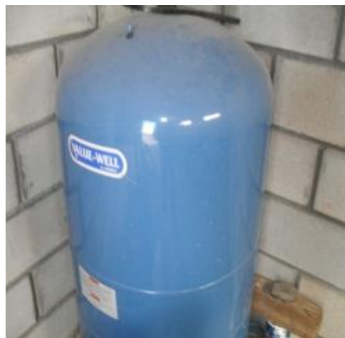
Foto 38. Tanque hidroneumático
