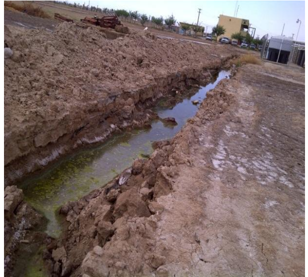
Foto 42. Situación actual de la PTAR
