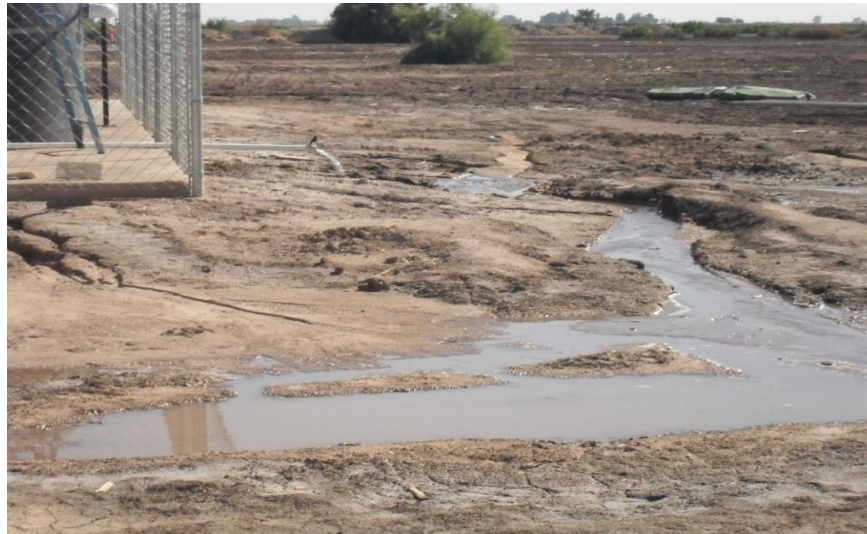
Foto 40. Demasías del tanque efluente causando una laguna
