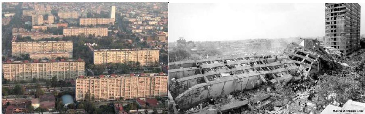
Imagen 6: Unidad Nonoalco-Tlatelolco y a la derecha Edificio Nuevo León de Unidad Nonoalco-Tlatelolco después del terremoto en 1985.
