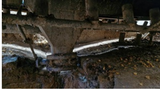
Figura 3.5: Salida de nejayote inferior del tanque
