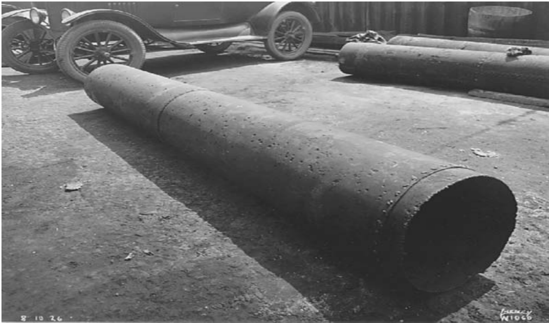
Figura 2.3 Corrosión por picaduras en tubería de suministro de agua a causa de corrientes parásitas. (Fuente: R. Roberge Pierre. Corrosion Engineering Principles and Practice. McGraw-Hill, Inc. 2008).
