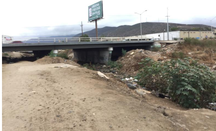
Figura 15 Vista sureste. Elaboración propia (2019).
