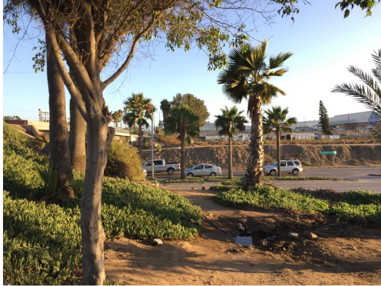
Figura 57 Estado físico de rotonda calle Esmeralda Vista oeste. Elaboración propia (2019).
