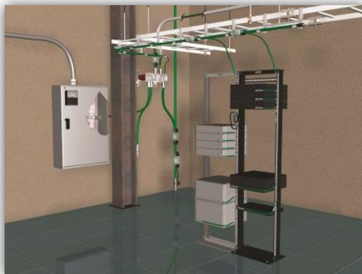
Ilustración 5: Cuarto de Telecomunicaciones
