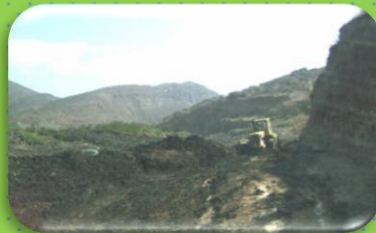
Figura 2. Deposito de biosólidos en terrenos posteriores de la PTAR.
