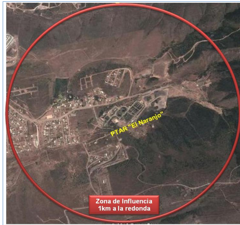
Figura 15. Vista panorámica de la ubicación de la PTAR “El Naranja” y la zona de influencia (Fotografía tomada de Google Earth, 2012).
