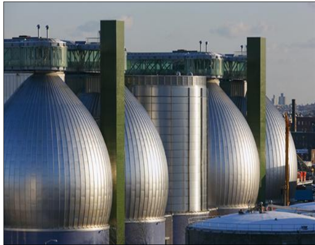
Fig. 2. Digestores anaerobios para recuperación de energía, Nueva York, E.U.A
