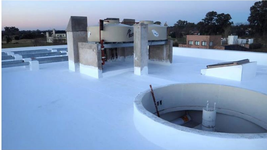
Figura 71. Aislamiento en techo con bloques de EPS.
