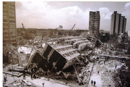
Figura 2 Daños en edificios en la Cd. de México a causa del sismo del 19 de septiembre de 1985.
