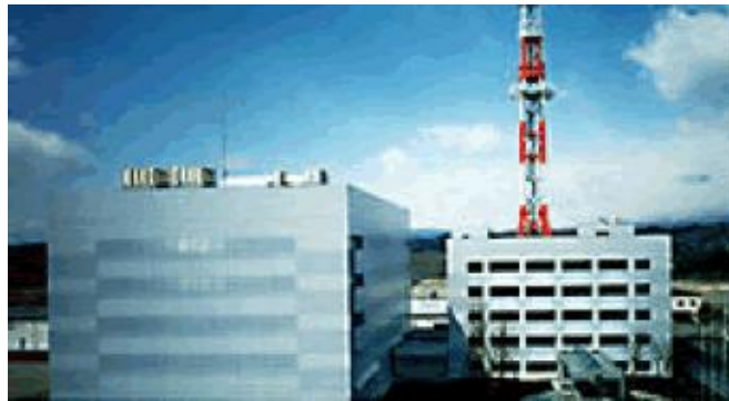
Figura 20 Centro de computación de la Empresa Eléctrica Tohoku.
