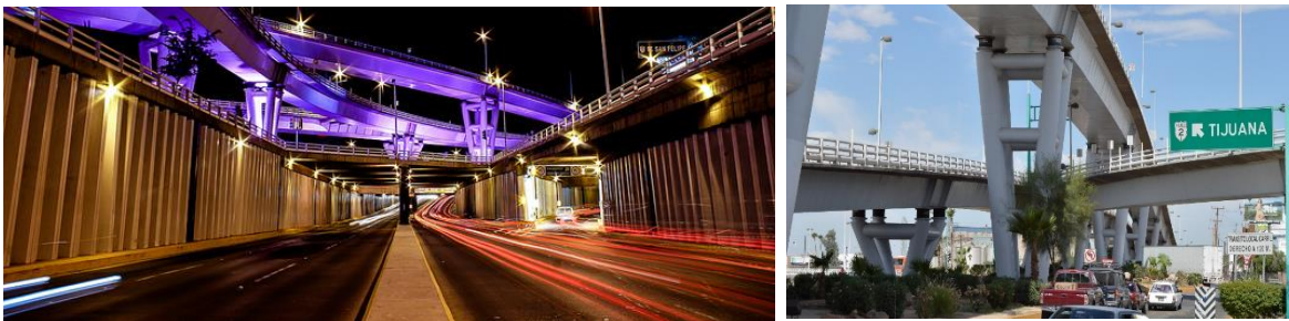
Figura 29 Aisladores de base colocados entre las pilas y el cuerpo del Distribuidor Vial Lázaro Cárdenas-López Mateos, en Mexicali, Baja California.
