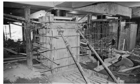
Figura 24 Aislaores en la Parliament House de Nueva Zelanda.
