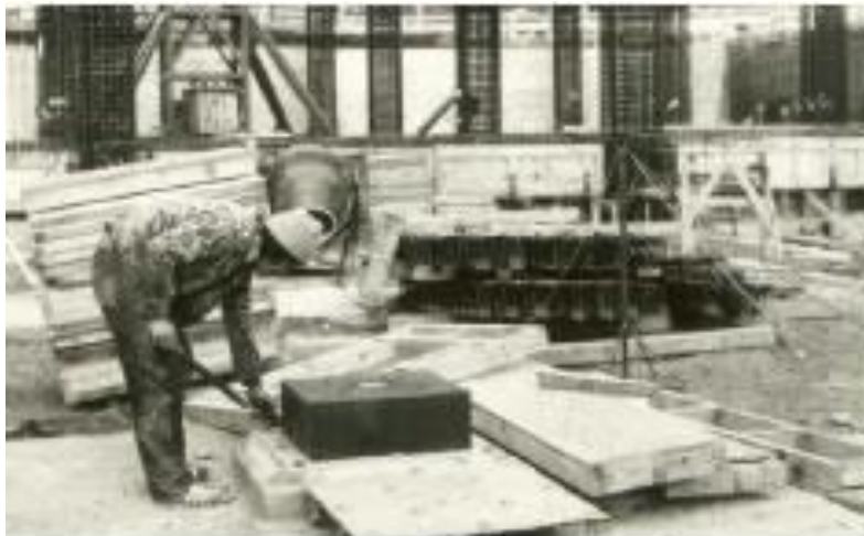
Figura 27 Aisladores en Edificio William Clayton en Nueva Zelanda.
