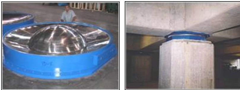
Figura 11 Dispositivo péndulo de fricción (FPS).
