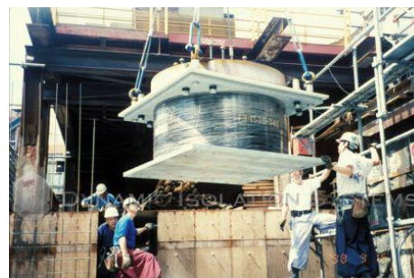
Figura 22 Aisladores de base debajo del High City Kiyosumi.
