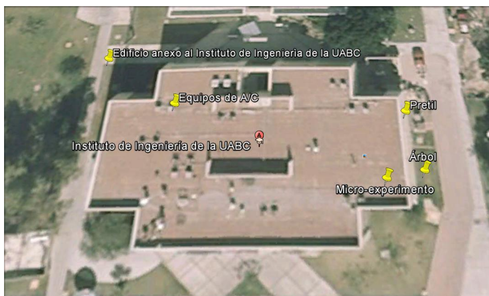
Figura 5. 1: Ubicación del experimento y equipos de aire acondicionado.
