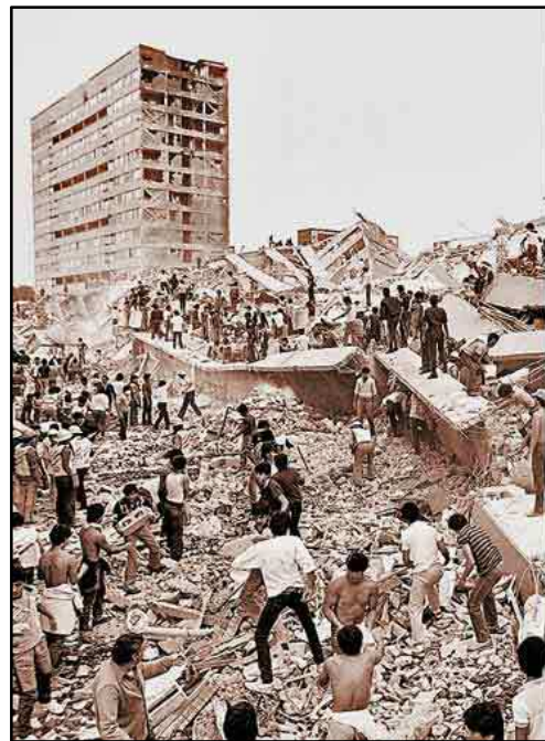
Figura 10: Edificio Nuevo León de la Unidad Habitacional Tlatelolco (UNIVERSAL; 2009)
