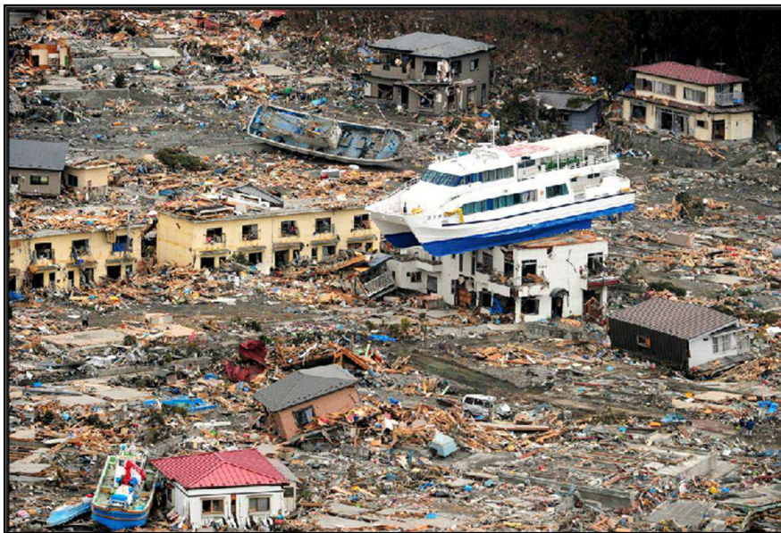
Figura 16: Un barco termina posado sobre un edificio tras el tsunami (Mundo2, 2014)
