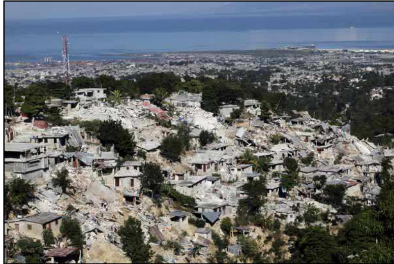
Figura 12: Vista de una zona de Puerto Príncipe tras el seísmo (20Minutos2, 2014)
