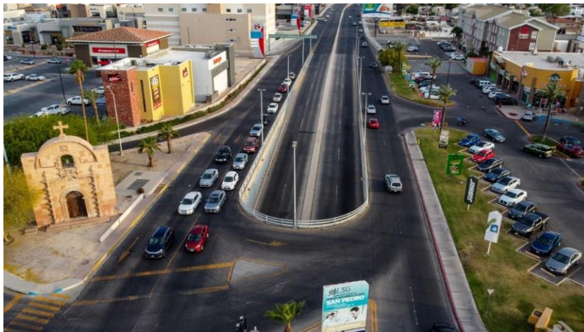
Figura VIII. Vista a Sur de Calz. Cetys y Blvr. Gómez Morín
