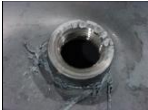
Fig. No. 14.4 – Material depositado en las cuerdas de la rosca.
