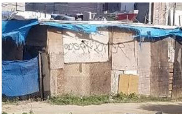
Vivienda de material ligero
