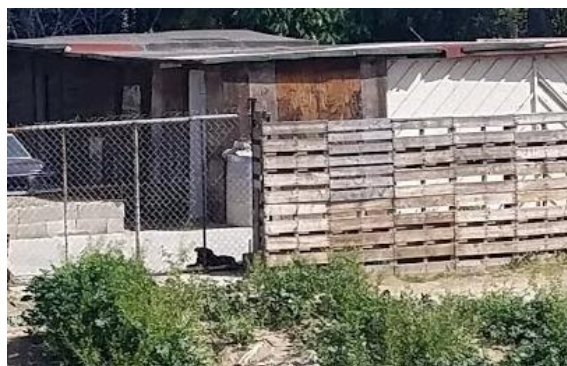
Vivienda de madera
