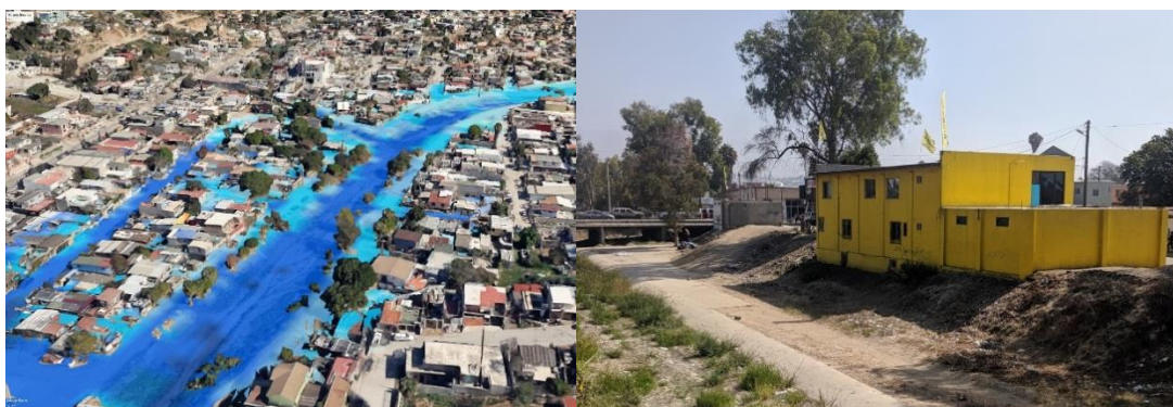
Figura 6. Viviendas en áreas de inundación.
