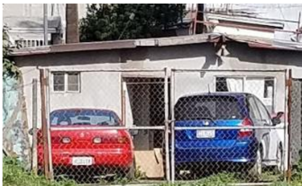
Vivienda de mampostería de 1 piso
