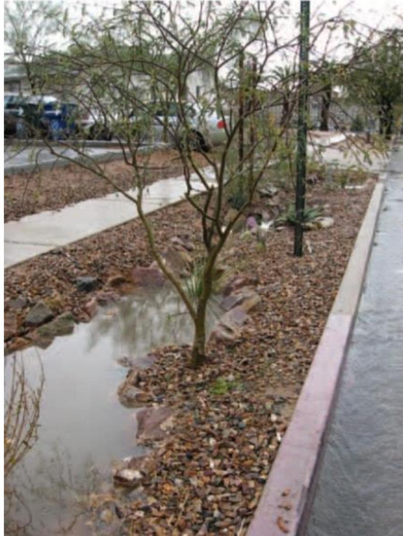
*Imagen 5. Ejemplo de jardinera con depresión para la captura de agua pluvial. Fuente: WMG, 2012*
