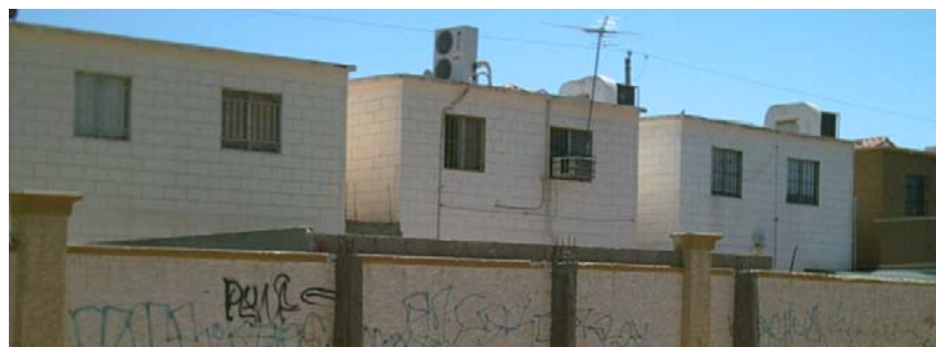
Figura 3.4 Viviendas construidas con muro de bloque y losa de concreto
