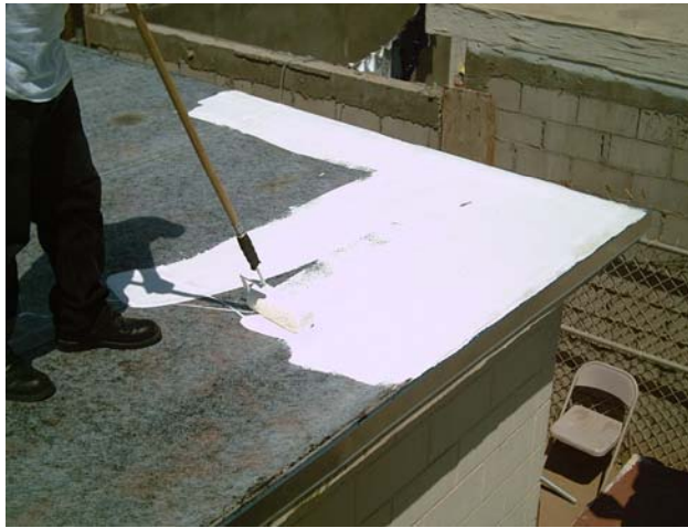
Figura 3.10 Reflectividad de un techo en el momento de aplicar pintura elastomérica
