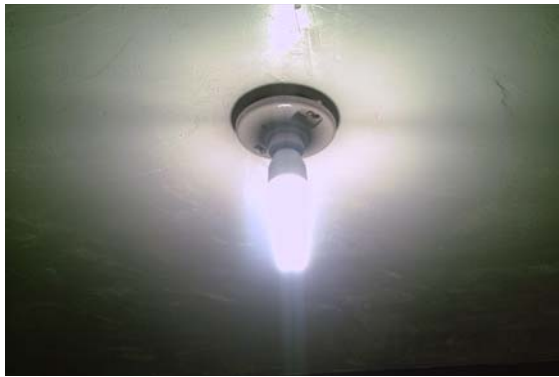
Figura 3.8 Foco fluorescente de 13 W
