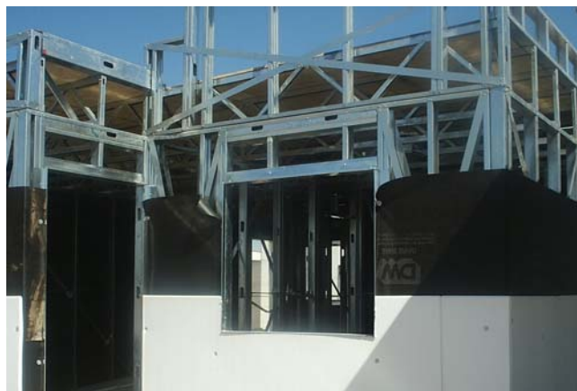
Figura 2.11 Estructura del sistema ARMOUR
