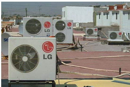
Figura 2.16 Equipos de aire acondicionado tipo unidades divididas con una manejadora de aire ( split )
