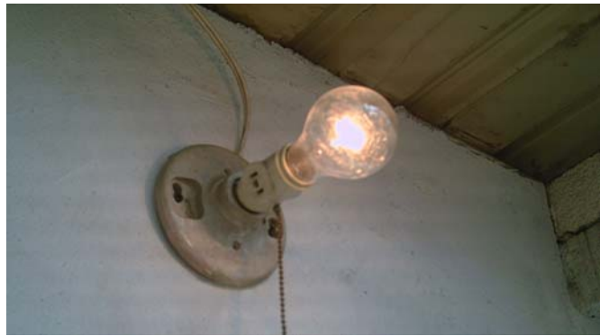
Figura 3.9. Foco incandescente de 75 W
