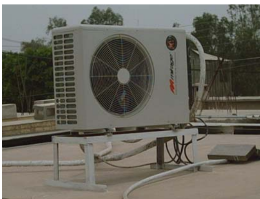
Figura 2.17 Funcionamiento y representación de equipo de aire acondicionado tipo unidades divididas con dos manejadoras de aire ( multisplit )
