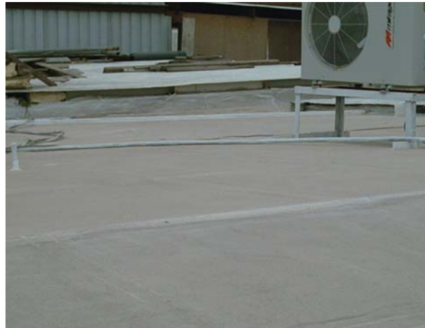
Figura 3.11 Pérdida de reflectividad en un techo 2 meses después de aplicar pintura elastomérica
