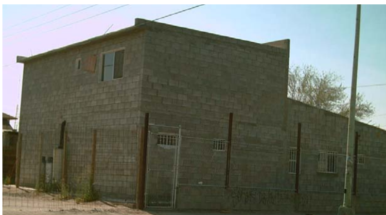
Figura 3.5 Vivienda con necesidad de aislamiento térmico
