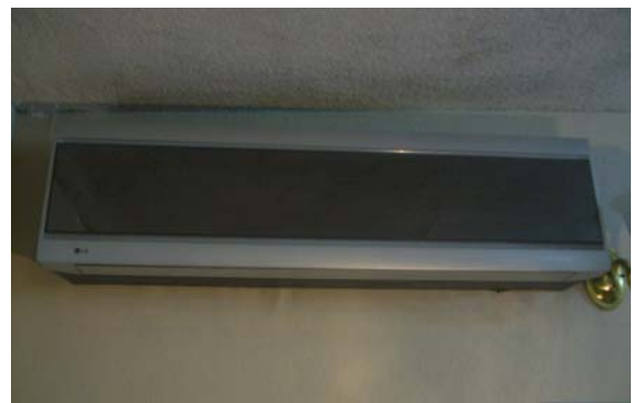
Figura 2.16 Equipos de aire acondicionado tipo unidades divididas con una manejadora de aire ( split )
