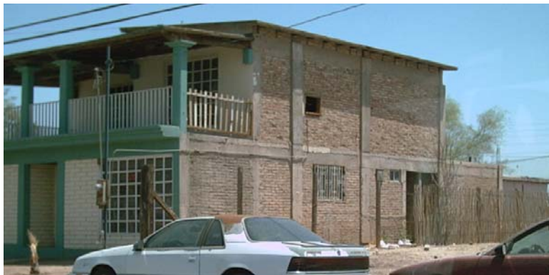
Figura 3.3 Vivienda de ladrillo con techo de madera
