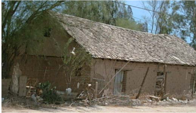
Figura 3.1 Vivienda de adobe
