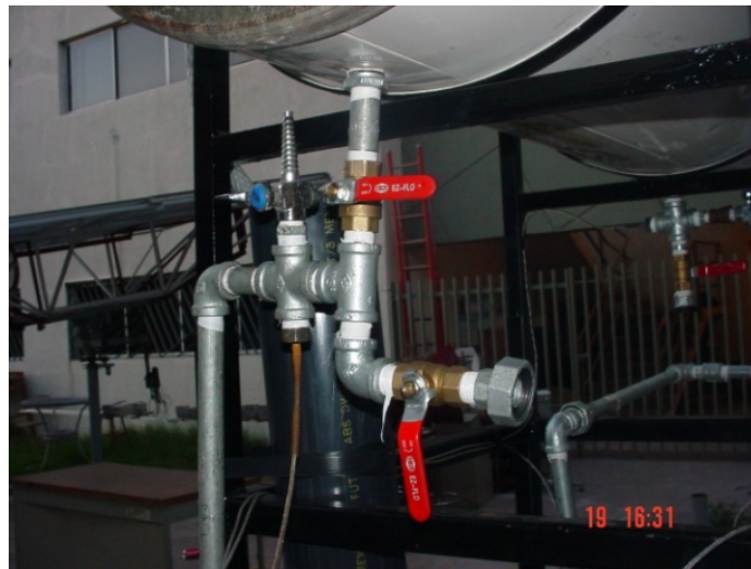
Figura 4.20 Arreglo para flujo forzado y termosifón.
