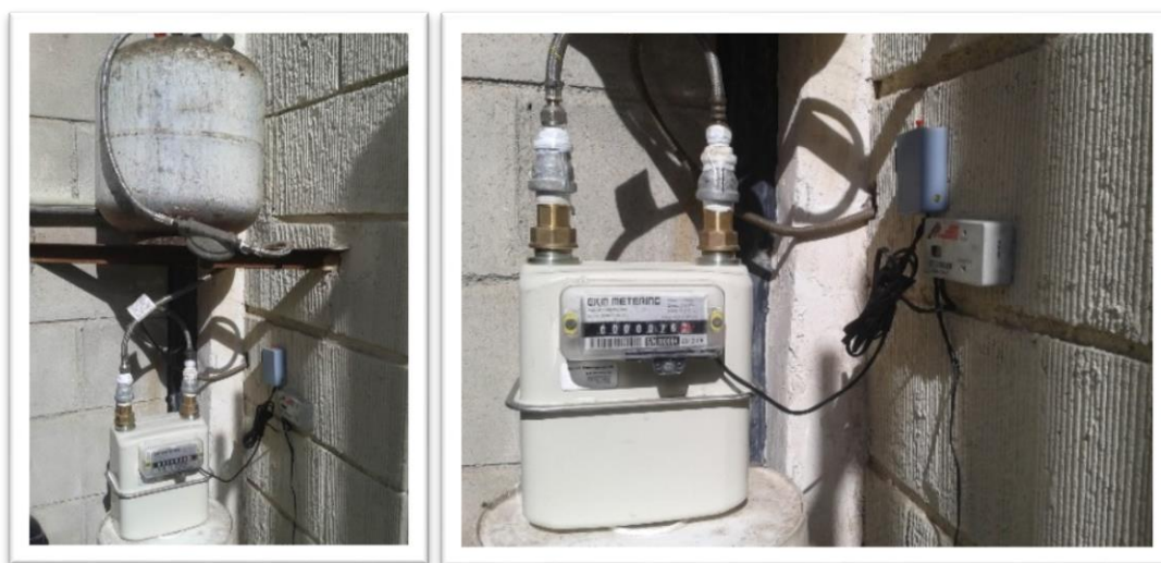
Figura 3.12: Prueba en campo de Sadga y CT Logger.
